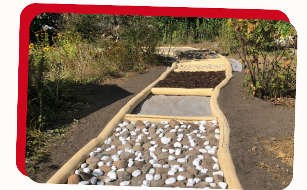
Endphase der Bauarbeiten
