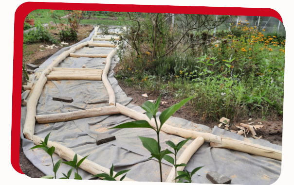
Beginn der Bauarbeiten
