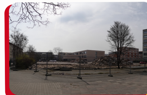
Bauarbeiten auf dem Quartiersplatz
