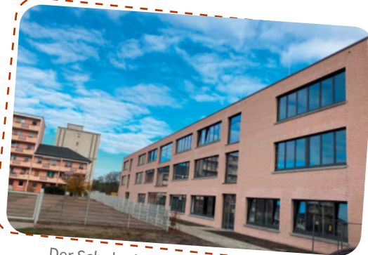
Der Schulanbau des Heinitz-Gymnasiums
