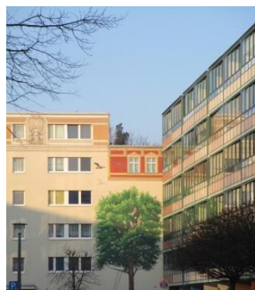
Sanierter Bestand Brückenstraße / Friedrich-Engels-Ring
